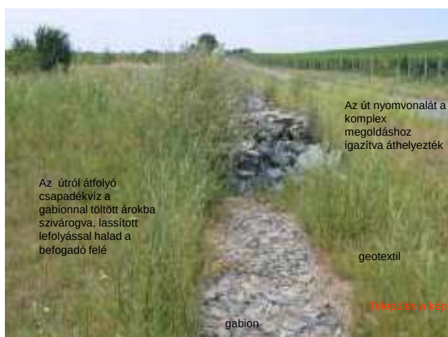
4. ábra: feltöltött vízelvezető árok
