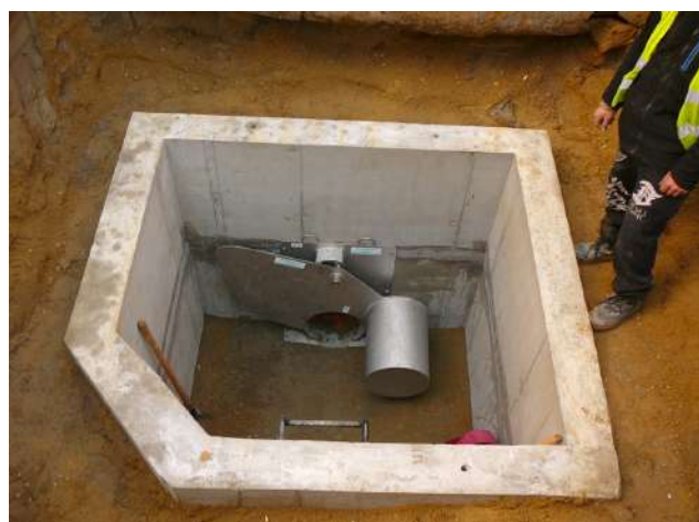
4. ábra HydroSlide lefolyás szabályozó beépítve - Budapest, Bethlen u. (Ebeplan Kft. - Fotóarchívum)
