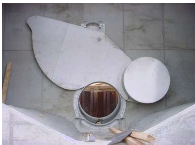
2. ábra HydroSlide Mini lefolyás szabályozó (Steinhardt GmbH. – Gyártmánykatalógus)
