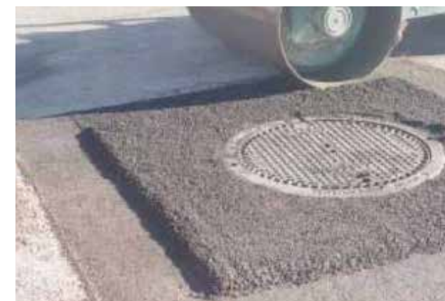
2. és 3. fotó A fedlap aszfaltba ágyazása és behengerlése. ([1]Gyártmány ismertető)
