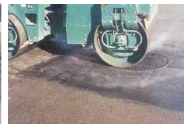
2. és 3. fotó A fedlap aszfaltba ágyazása és behengerlése. ([1]Gyártmány ismertető)
