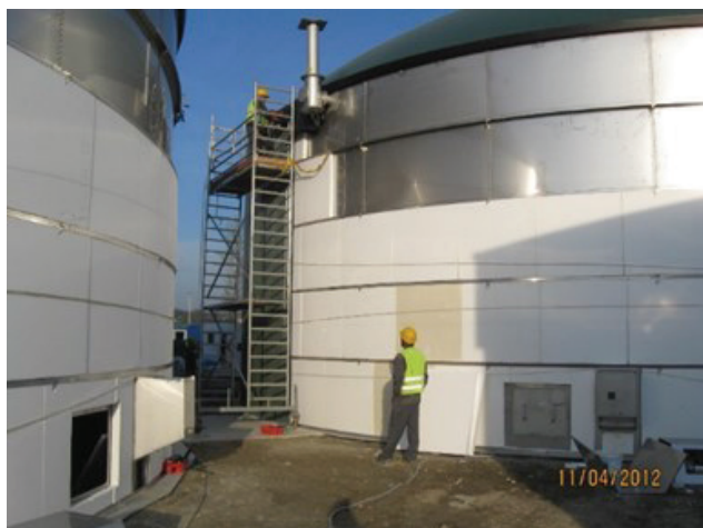
24. ábra. Szigetelés felhordása acél reaktorra
