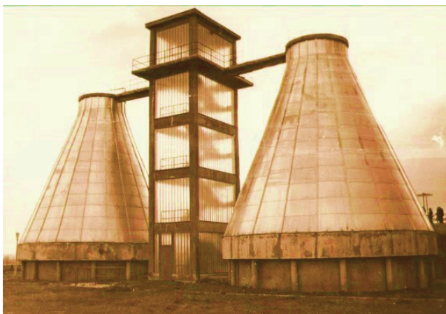
13. ábra. Forgástesthez hasonló rothasztó kialakítás magyarosítva Kaposváron ( 2 \times 1\,000\text{ m}^3 )
