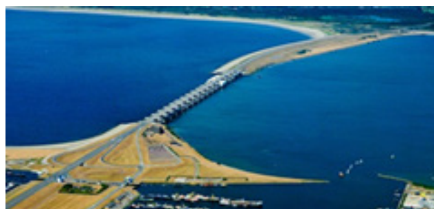
16-17 sz. ábrák a Delta mű leghosszabb gátja és nyitható zsilip kapuinak képe
