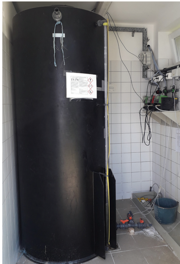
1 m 3 térfogatú NaOCl vegyszeradagoló tartály egy KEOP beruházás során létesült vízműben
