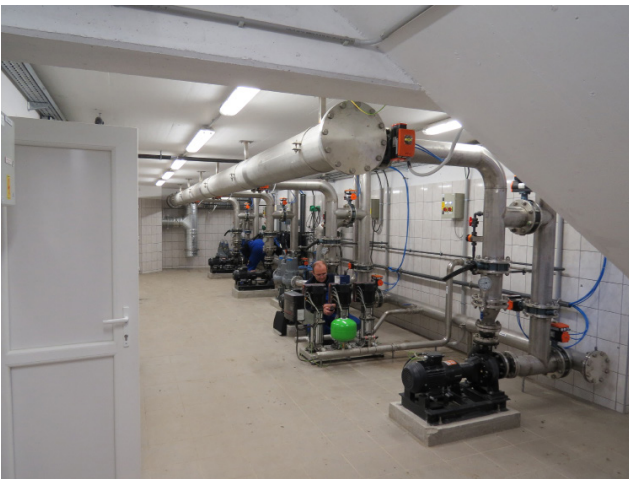
Membrán gépészet: balra: szivattyúház jobbra: biológiai és membrán fúvók
