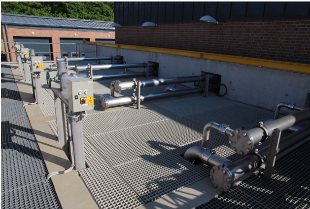
Az MBR membrán medencéi – LEAP levegőztetéssel Hőszivattyú
