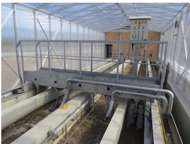
Homok és zsírfogó hosszanti átfolyású iker műtárgyban, zárt térben
