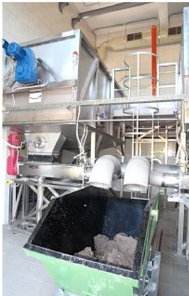
A mechanikai tisztítás berendezései: balra léptető-rács, jobbra forgó-dobszűrő
