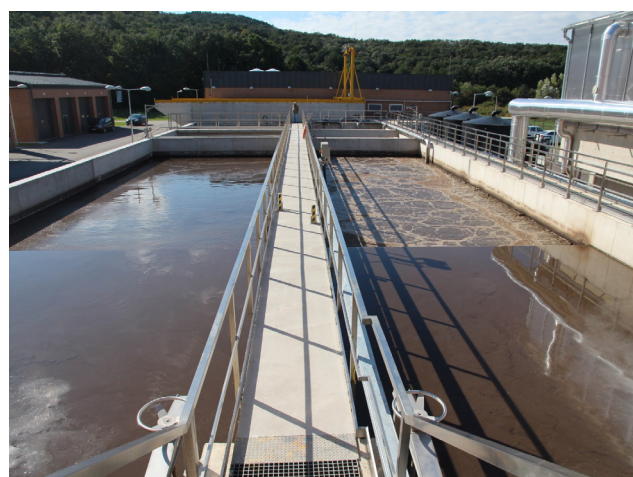
Biológiai anoxikus medencék és aerob medencék levegőztetés szabályozással
