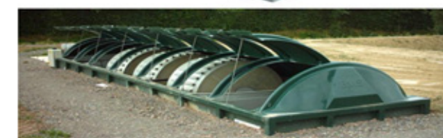
4. ábra. Forgó tárcsás kontaktorok, melyeknél a tárcsákról leszakadó iszaprészeket megfelelő szűrővel, ülepítéssel kell visszatartani (Fazekas et al., 2015).
