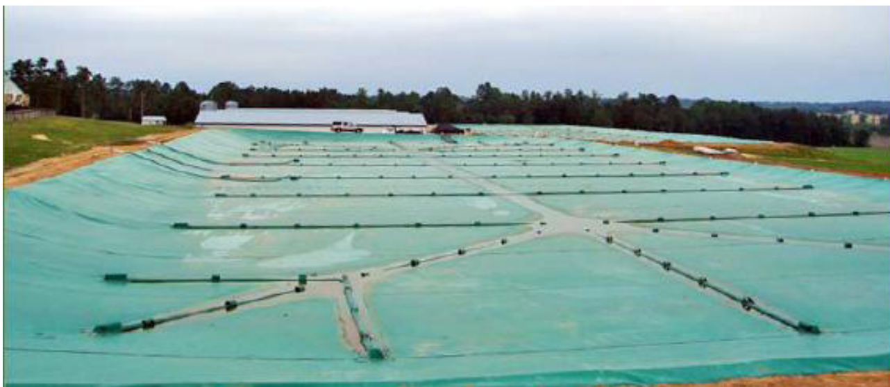
4/2. ábra Egy fedett anaerob lagúna fotója (Forrás: US EPA: Anaerobic Digester Designs. Covered Lagoon , 2011)
