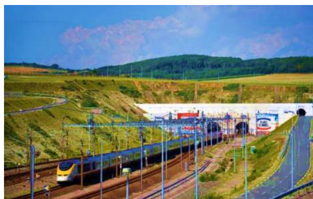
13. ábra Az alagút francia oldali bejárata
