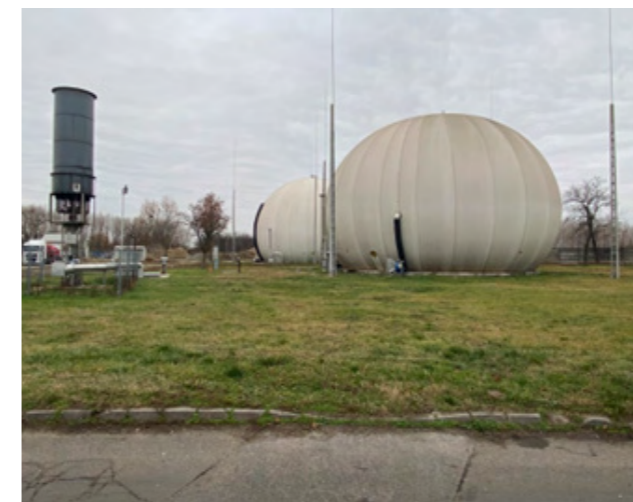
2. kép. Rejtett lángú gázfáklya és a gáztárolók a Dél-pesti Szennyvíztisztító Telepen (Forrás: saját készítés)
