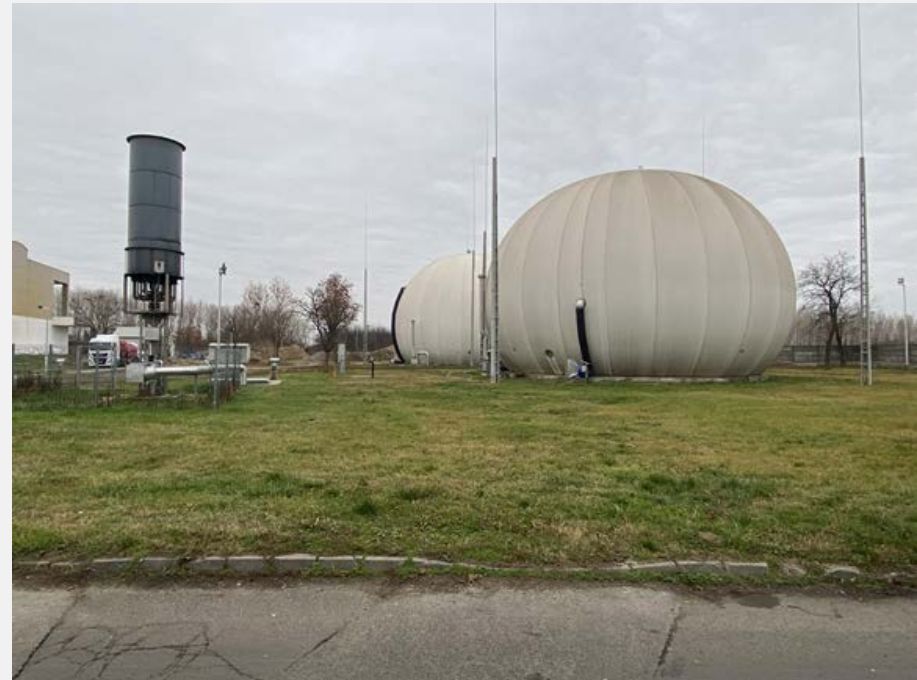
A telep biogáz tárolói is a rejtettlángú fáklya Forrás: saját készítés
