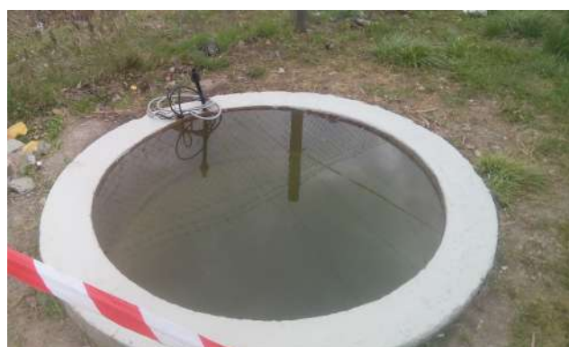
2. kép: Utólagos víztartási próba javított kármentő medencében
