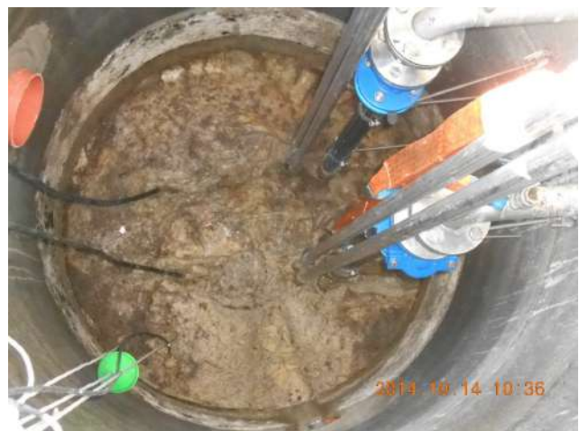
5. kép: Jelentős szális anyag terhelés az átemelőben
