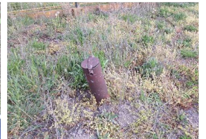
Részben „kiszántott” monitoring kút (a szerző saját felvétele, 2019.)
