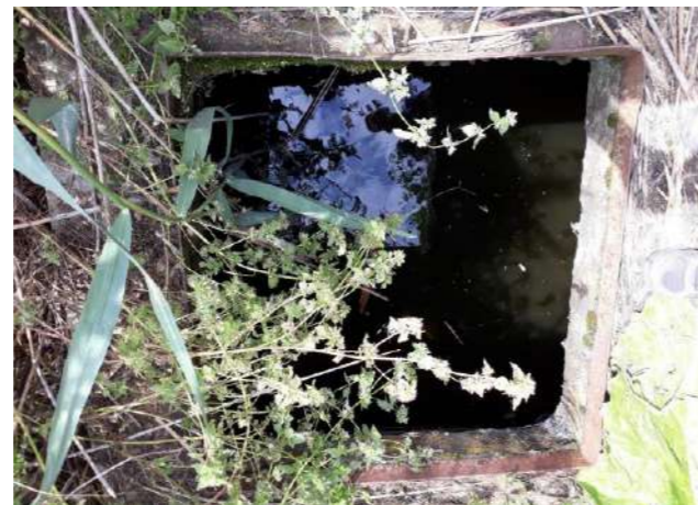
Használaton kívüli kút lezáratlan aknája település határában, a termőföldön (a szerző saját felvétele, 2019.)
