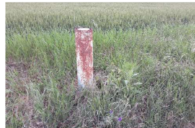
Jelentős mértékben korrodált, védelem nélküli kútfej-szellőzőcső kivezetés a talajon keresztül (a szerző saját felvétele, 2019.)
