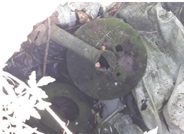
Nem teljes mértékben zárt kútfej, a kútaknában pedig oda nem illő anyagok találhatóak (a szerző saját felvétele, 2019.)
