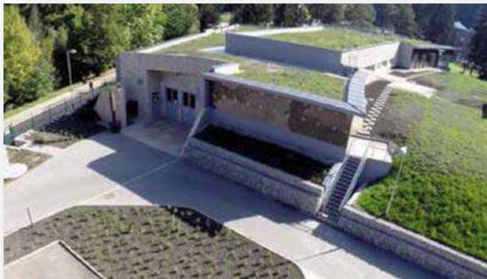
Az új technológiai épület északi homlokzata
