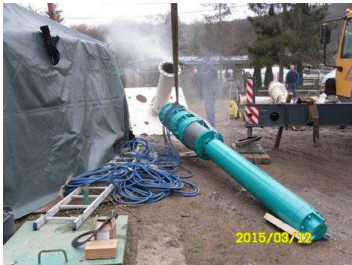
Szivattyúcsere az Új Kútban
