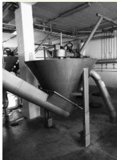
6. számú kép: HUBER Rotamat RoSF3 homokosztályozó
