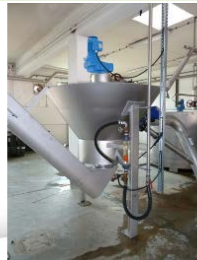
7. számú kép: HUBER Rotamat RoSF4 homokmosó
