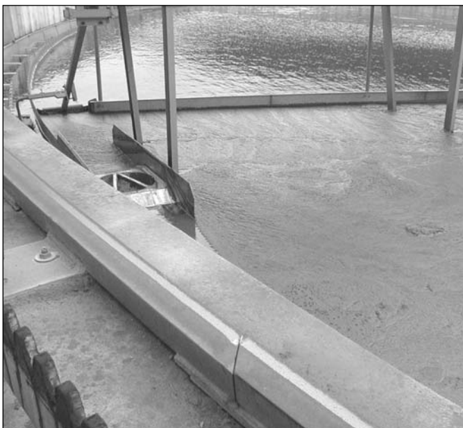
10. ábra. A köralaprajzú utőulepítő klasszikus habfőzője
