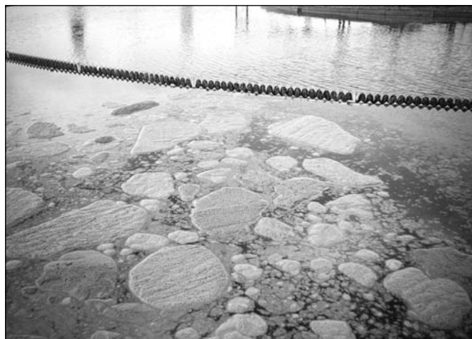
5. ábra. A biotermészet nagymértékű elúszása az utóülepítőből a merülő-fallal nem védett elvezető vályúba
