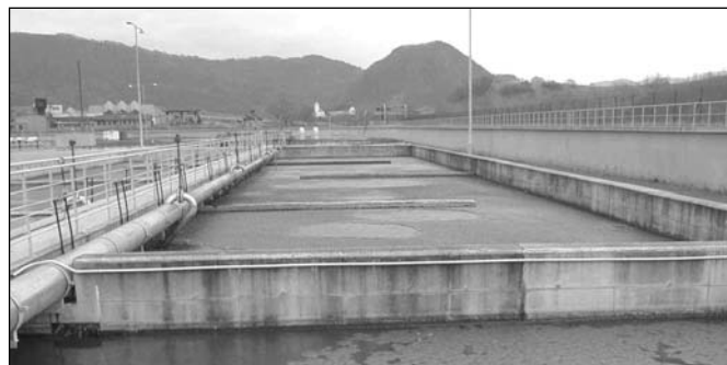
2. ábra. Szekciókra osztott eleveniszapos medence, melyben a hab a felszínen szabadon eltávozik
