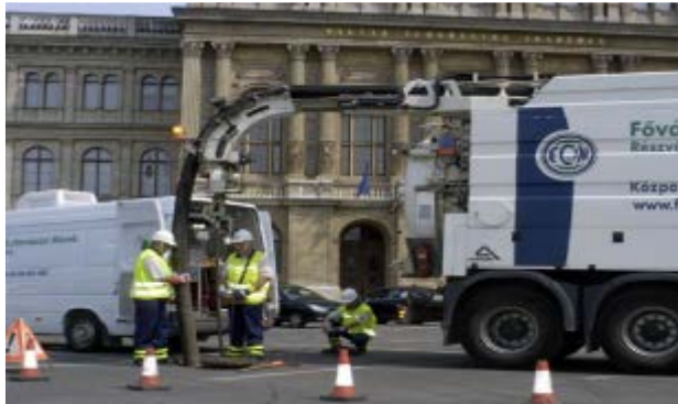
CSATORNA HÁLÓZAT TISZTÍTÁS
